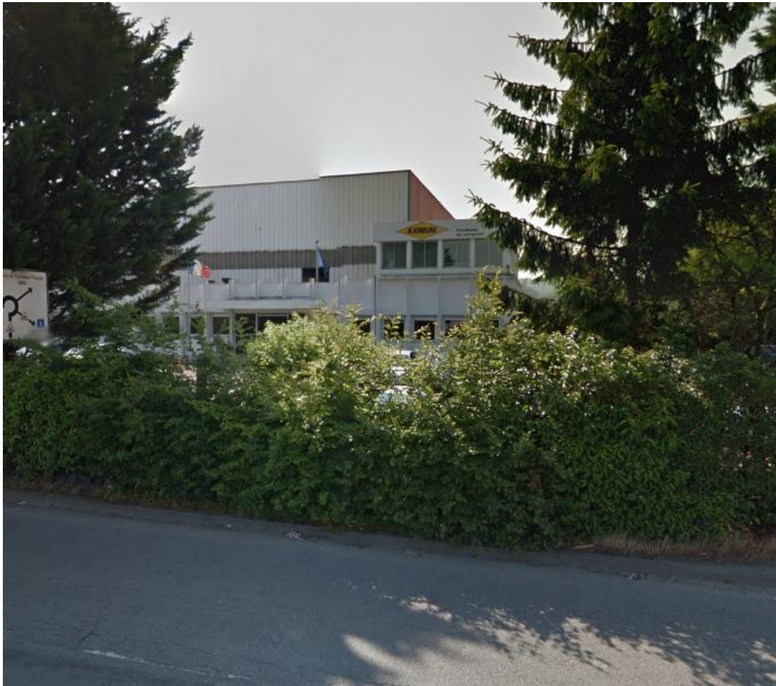
Figure 2 : Vue des bâtiments côté rue du Marais Sec
