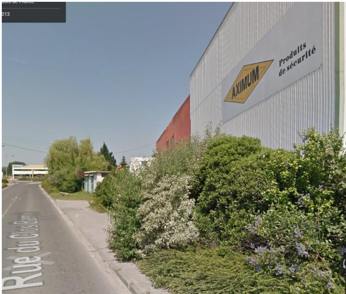
Figure 3 : Vue des bâtiments côté rue du Clos Barrois
