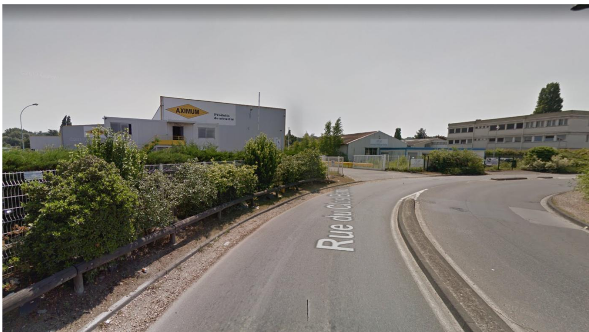
Figure 4 : Vue des bâtiments (profilage) côté rue du Clos Barrois
